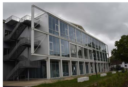
Le Technopôle Hub&Go
